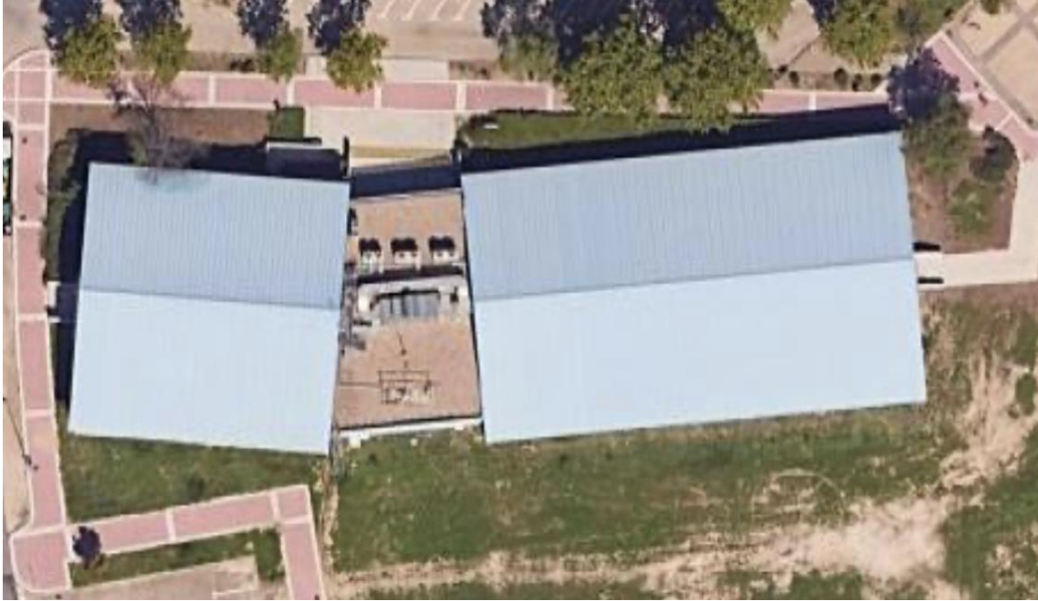
Figura 1. Vista aérea del edificio Aulario Polivalente IV
